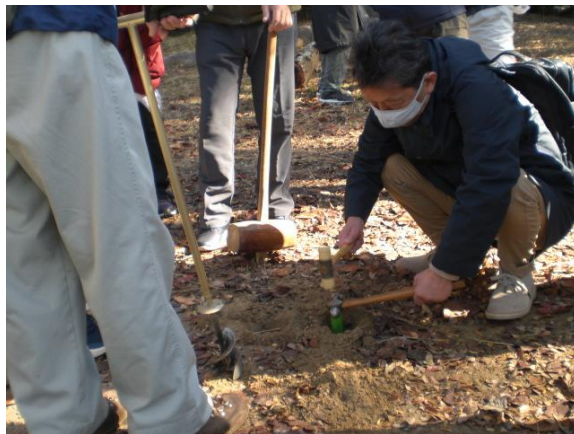
グリーンパイル打込み（浅田樹木医）
