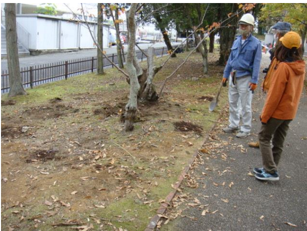
割竹埋設、根株掘り完了全景 (ソメイヨシノ)
