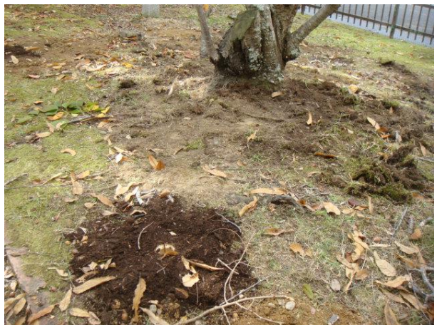
割竹埋設完了、深植え根株の掘起こし完了
