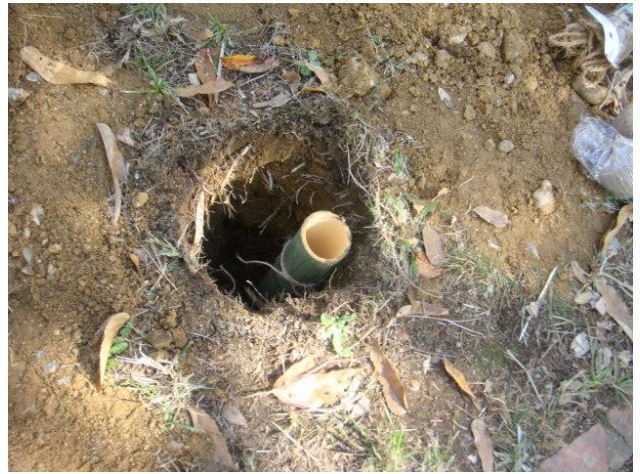
掘った穴に入れる
