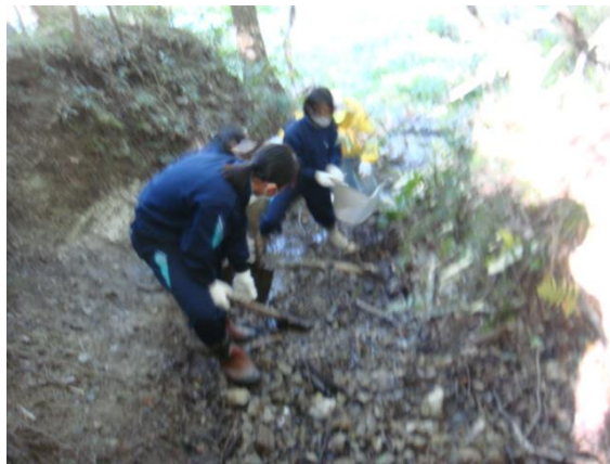
崩壊地に土留め作り
