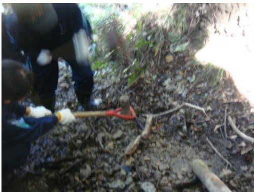
掛けやで杭打ち（前日撤去支柱再利用）
